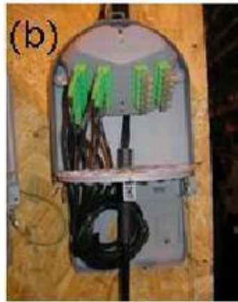
Рисунки событий критического изгиба волокна в сети доступа: (а) изгибы на углах плинтуса; (б) кольца волокна малого радиуса в распределительной абонентской коробке; (в) и кабель, согнутый скобами.
