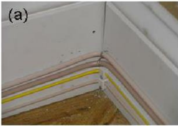
Рисунки событий критического изгиба волокна в сети доступа: (а) изгибы на углах плинтуса; (б) кольца волокна малого радиуса в распределительной абонентской коробке; (в) и кабель, согнутый скобами.
